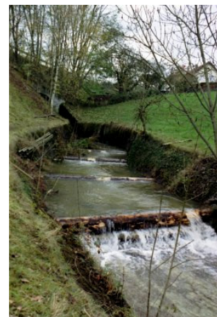
Die 2. Etappe bis zum 1. Tunnel ist geschafft.
