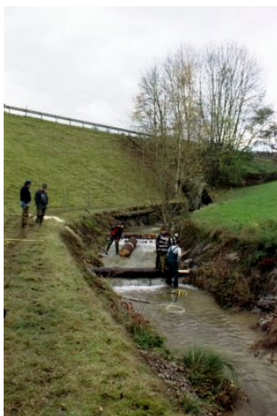
Die Stämme werden in die vorbereiteten Kerben gelegt.
