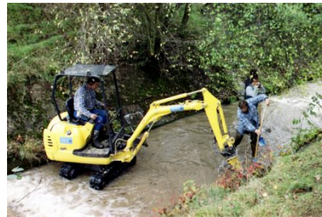
Unterdessen werden mit dem Bagger die Kerben rausgespitzt, in die die Föhrenstämme gelegt werden.
