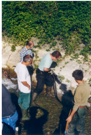
Die Nischen werden von Hand mit dem Presslufthammer rausgespitzt. Hier im unteren Teil des Baches waren die Seitenwände extrem dick und der Beton war zäh.
