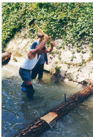
Hans Brauchli schlägt einen Stahldorn ein.
