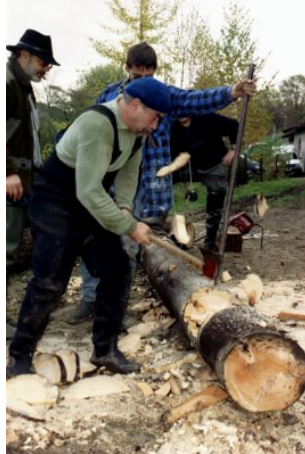
Danach werden sie für den Einbau vorbereitet.
