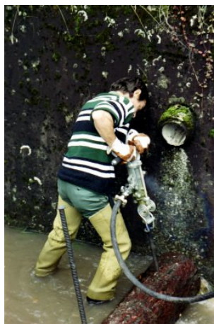
Mittels Pressluftbohrer werden die Löcher gebohrt und danach die Eisen eingeschlagen.
